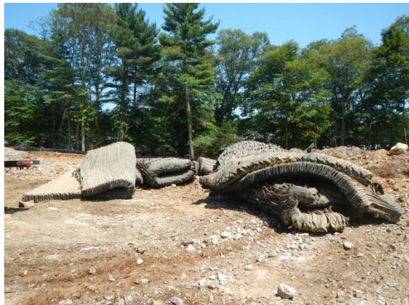
Blasting mats on site
